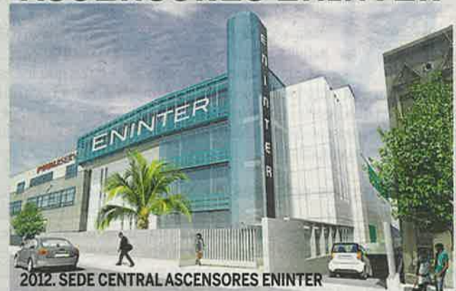
El proyecto más importante para el 2012 es la Sede central de ASCENSORES ENINTER, la principal empresa nacional de instalación y mantenimiento de ascensores. Actualmente en construcción
